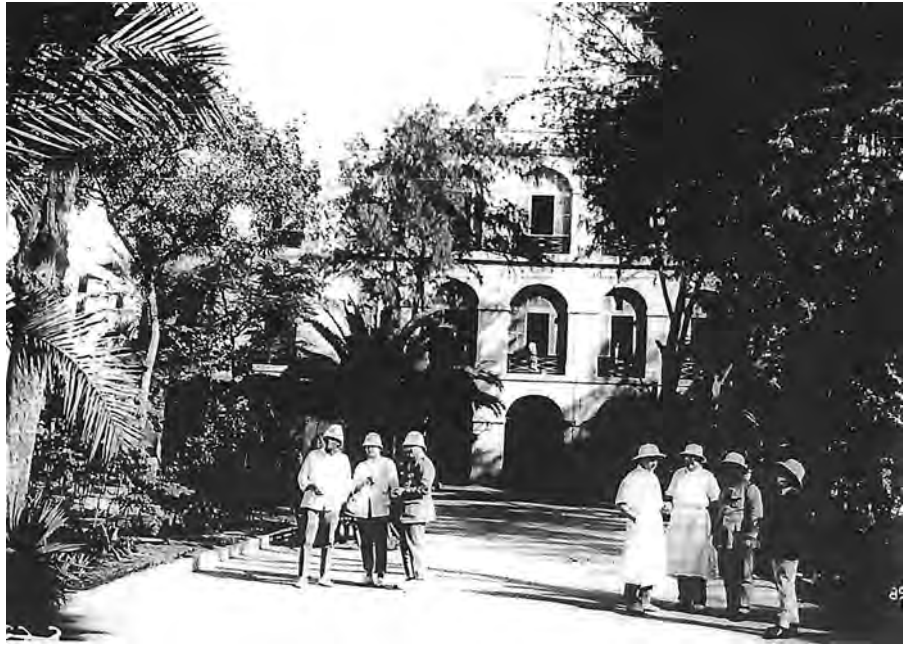
Hôpital de Saint-Louis du Sénégal, photographie prise en 1930, mais les bâtiments ont été construits au début du siècle.
